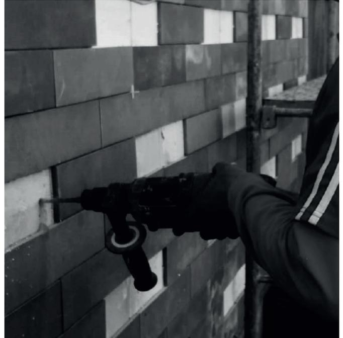
Una vez instalados los módulos con adhesivo se recomienda esperar unos 20 minutos y luego comenzar a perforar con la broca lo suficientemente profundo para que el tarugo tipo clavo pueda activarse. Se debe usar un martillo de goma para introducir el vástago hacia el interior hasta el punto suficiente para que la arandela del tarugo quede bajo la superficie de poliestireno expandido. La arandela de la fijación mecánica debe quedar a ras de la superficie del poliestireno expandido.
