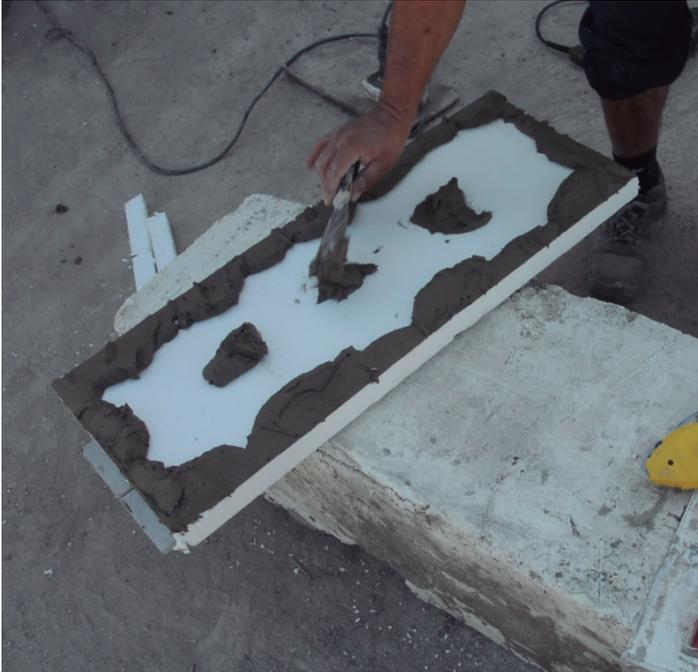
Se sugiere aplicar el adhesivo por todo el borde del módulo EIFS y en el centro agregar puntos, similar a la imagen superior. Esto permitirá ir corrigiendo el pegado de los módulos para que queden a plomo ya que se genera un efecto de vacío que permite mayor maniobra al momento de corregir. Otra opción es con una llana dentada hacerle estrías verticales en la parte posterior del módulo EIFS. Se deben seguir las indicaciones de los fabricantes del adhesivo.
